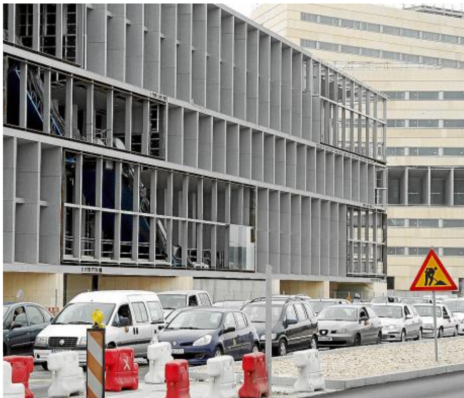
Passeig Marítim является одной из наиболее загруженных автомобильных магистралей города. Участок возле строящегося Palau de Congressos – наиболее проблематичный Фото: П. Бота
